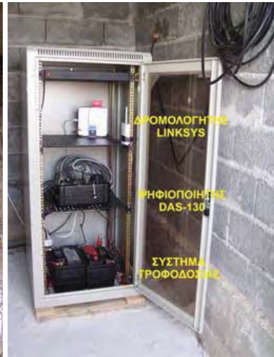
Σεισμολογικές Έρευνες: Περιφερειακός σεισμολογικός σταθμός. Όργανα ελέγχου και καταγραφής
