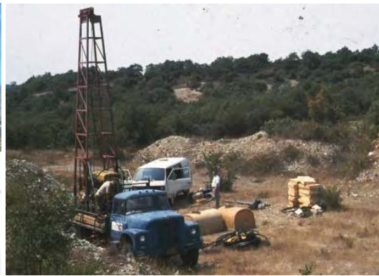
Γεωτρητικές εργασίες στην Καβυσσό Έβρου
