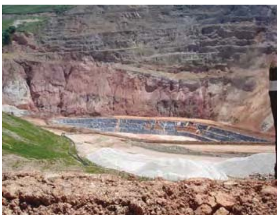
Λεκάνη υποδοχής καταλοίπων μεταλλο- λουργίας Χρυσού, Βόρεια Ισπανία
